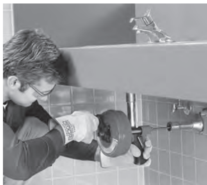
Slika 8 – Power-Spin upotrijebljen ručno
