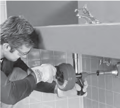
Εικόνα 8 – Χρήση του Power-Spin χειροκίνητα
