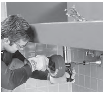
Kuva 8 – Power-Spin käsin käytettynä
