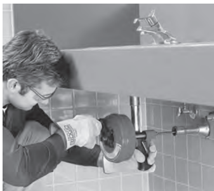
Рис. 8 – Использование Power-Spin вручную
