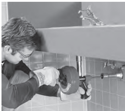
Slika 8 – Ročna uporaba naprave Power-Spin
