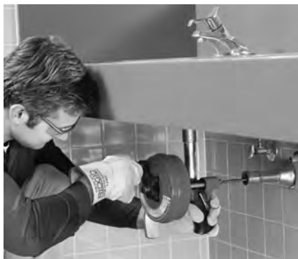
Figura 8 – Uso manual del Power-Spin
