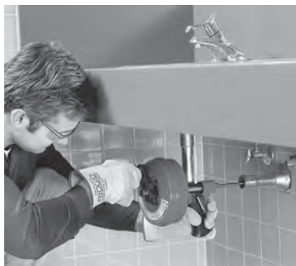
Rysunek 8 – Ręczna obsługa przepychacza Power-Spin
