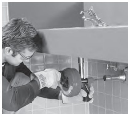
Abbildung 8 – Power-Spin manuell eingesetzt
