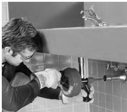
Figure 8 – Utilisation manuelle du Power-Spin
