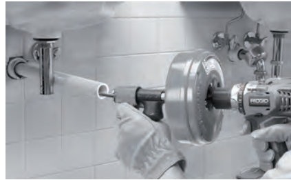
Şekil 7 - Kanal Açıklığının 4" (100 mm) Mesafesine Kanal Genişletme Örneği
