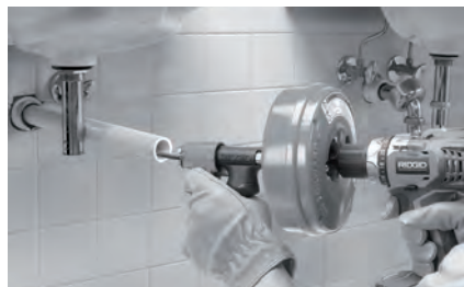
Obrázek 7 – Příklad prodloužení odpadu na vzdálenost 4" (100 mm) od vstupního otvoru odpadu
