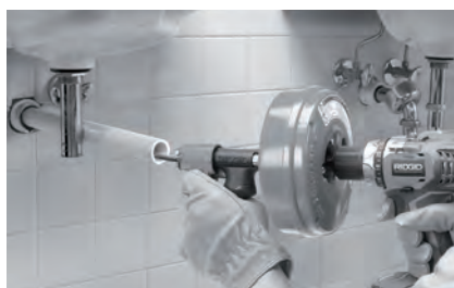
Figura 7 – Exemplu de prelungire a canalului la mai puțin de 4" (100 mm) de deschizătura canalului
