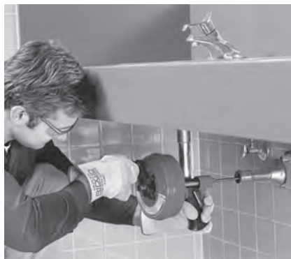
Figur 8 – Använda Power-Spin manuellt
