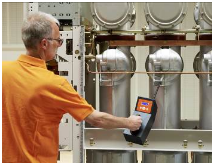
Рис. 2: Детектор по поиску элегаза
