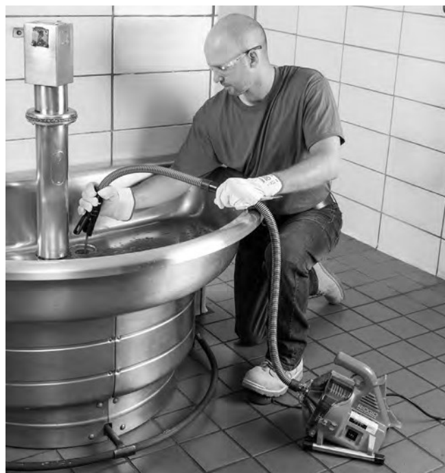
Рис. 11 – Извлечение троса
