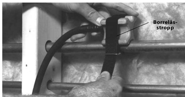
Figur 5 – Bruke frysehode med borrelås-stropp
