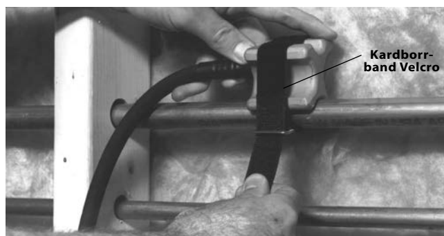
Figur 5 – Fästa fryshuvudet med kardborrband (Velcro)
