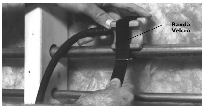
Figura 5 – Aplicarea capetelor de înghețare cu bandă Velcro
