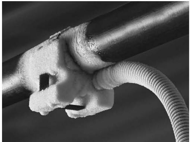
Figur 9 – Frysehode frosset til rør
