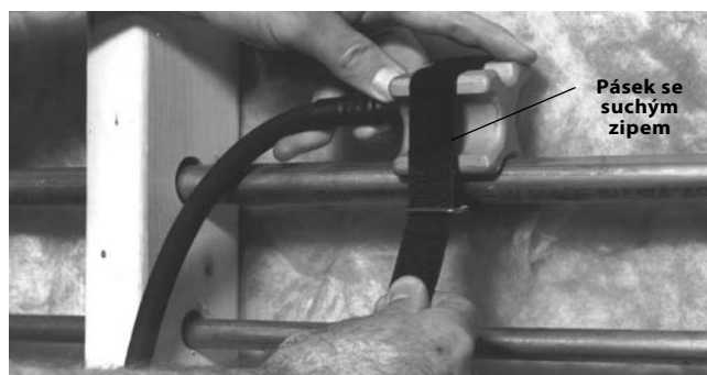
Obrázek 5 – Přichycení mrazicí hlavy pomocí pásku se suchým zipem
