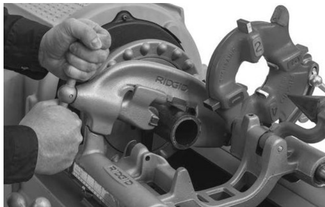
Рис. 21 – Резка трубы с помощью трубореза
